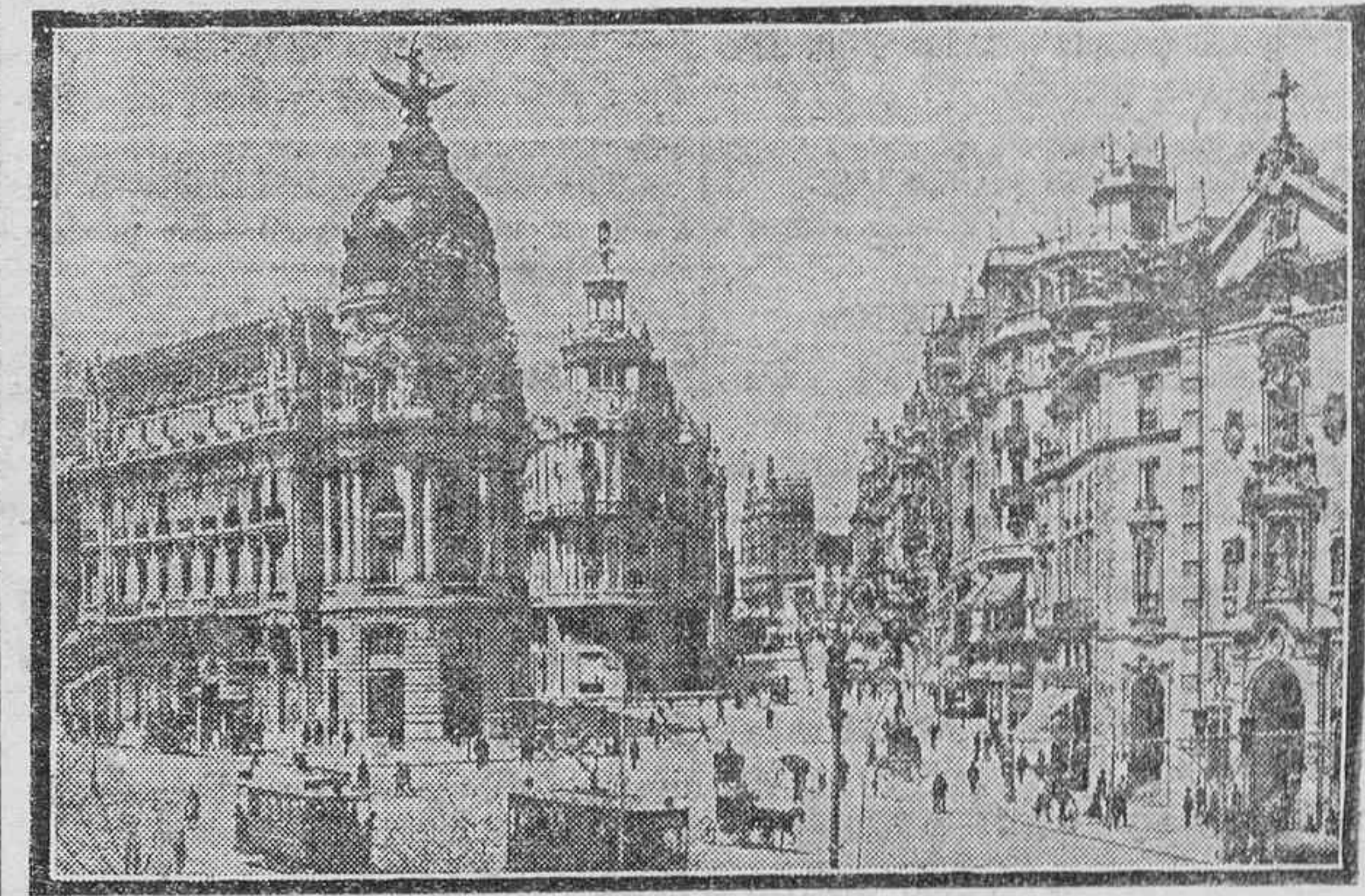
He aquí el principio de la Gran Vía de Madrid, consagración del rascacielos y del cemento. ¡El Madrid progresivo que arrolla a los castizos retrógrados!
