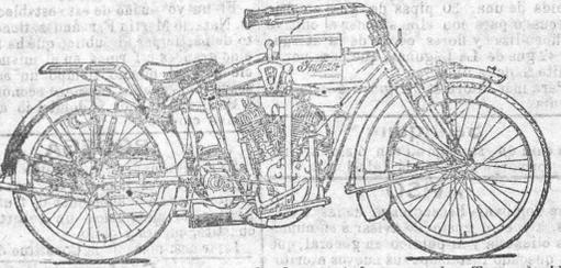
De cilindros con 7 HP nominales. Cuadro montado en muelles. Tres velocidades y embrague de discos secos a múltiple. Carburador automático con chorro auxiliar para baja velocidad. Ruedas grandes (28 X 3), propias para estas condiciones.
