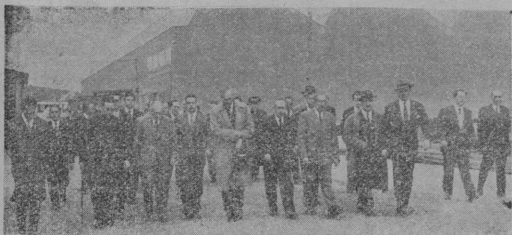
Jaén — El Ministro de Obras Públicas, señor Vigón, acompañado de las Autoridades y de las personalidades de su séquito, durante su visita a las obras e instalaciones del «Plan Jaén».
