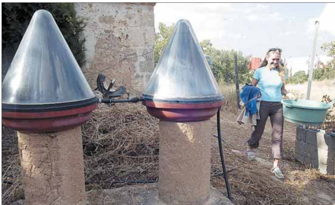
En la localidad de Navapalos se imparte un curso internacional de construcción en adobe
