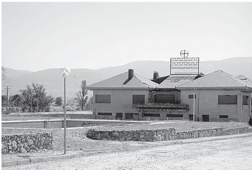
El edificio 'Fuenfría' que inicialmente iba a destinarse a centro social y que fue vendido a un particular / EL ADELANTADO
