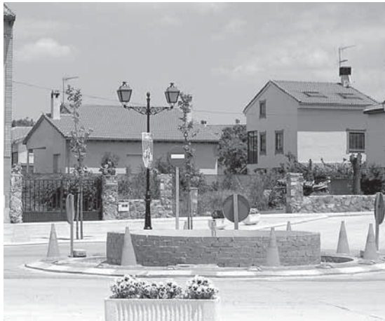
Entre los trabajos de urbanización se encuentra esta nueva rotonda / EL ADELANTADO
