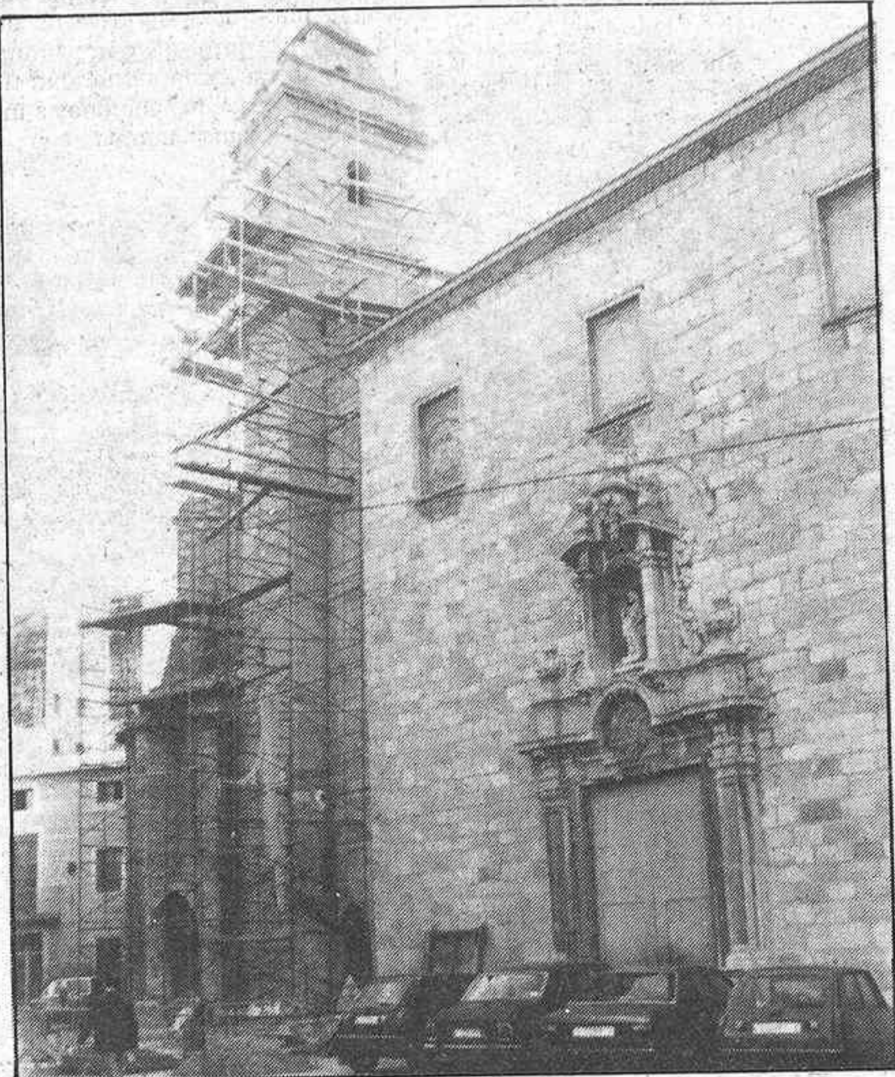
Junto a la torre todavía se observan los andamios utilizados en la restauración / P. GUERRERO
