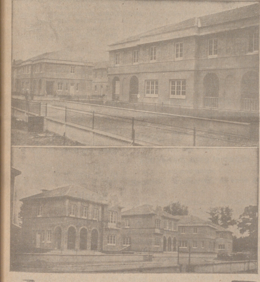
Fotografía de EL CASTELLANO. Arribar: Una casa bifamiliar. Abajor: Los dos edificios que los obreros conocen por el "Ayuntamiento" y la "Diputación"
