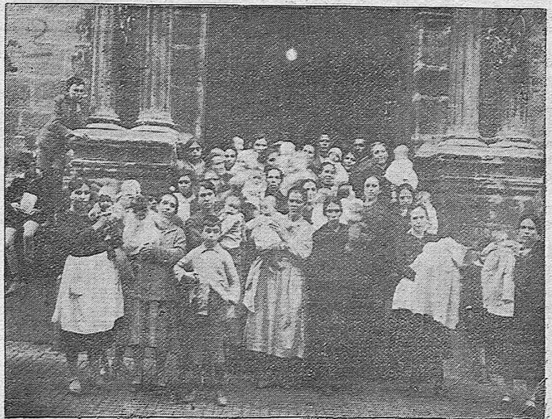
MONTORO.—Obreras que cobraron el subsidio de Maternidad.
