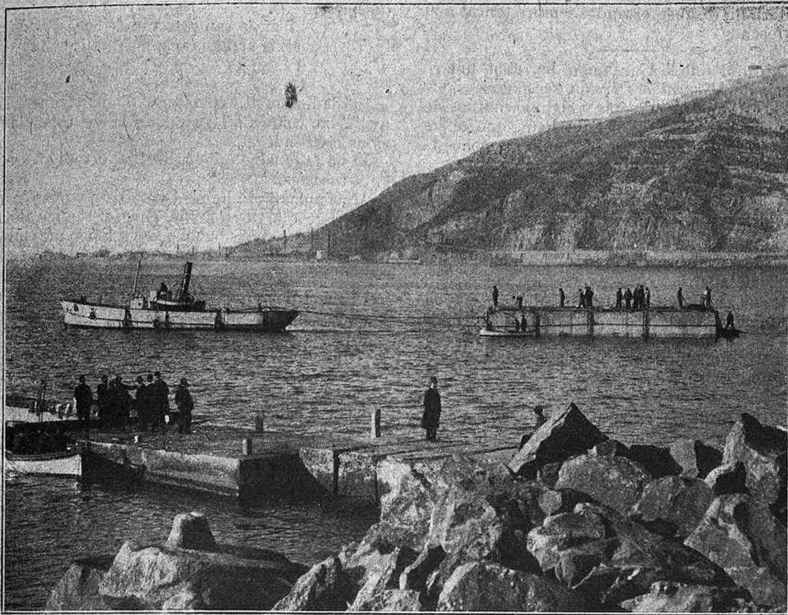
Colocació d' un bloc de 2,000 toneladas en las obras de prolongació del dich del Est.
