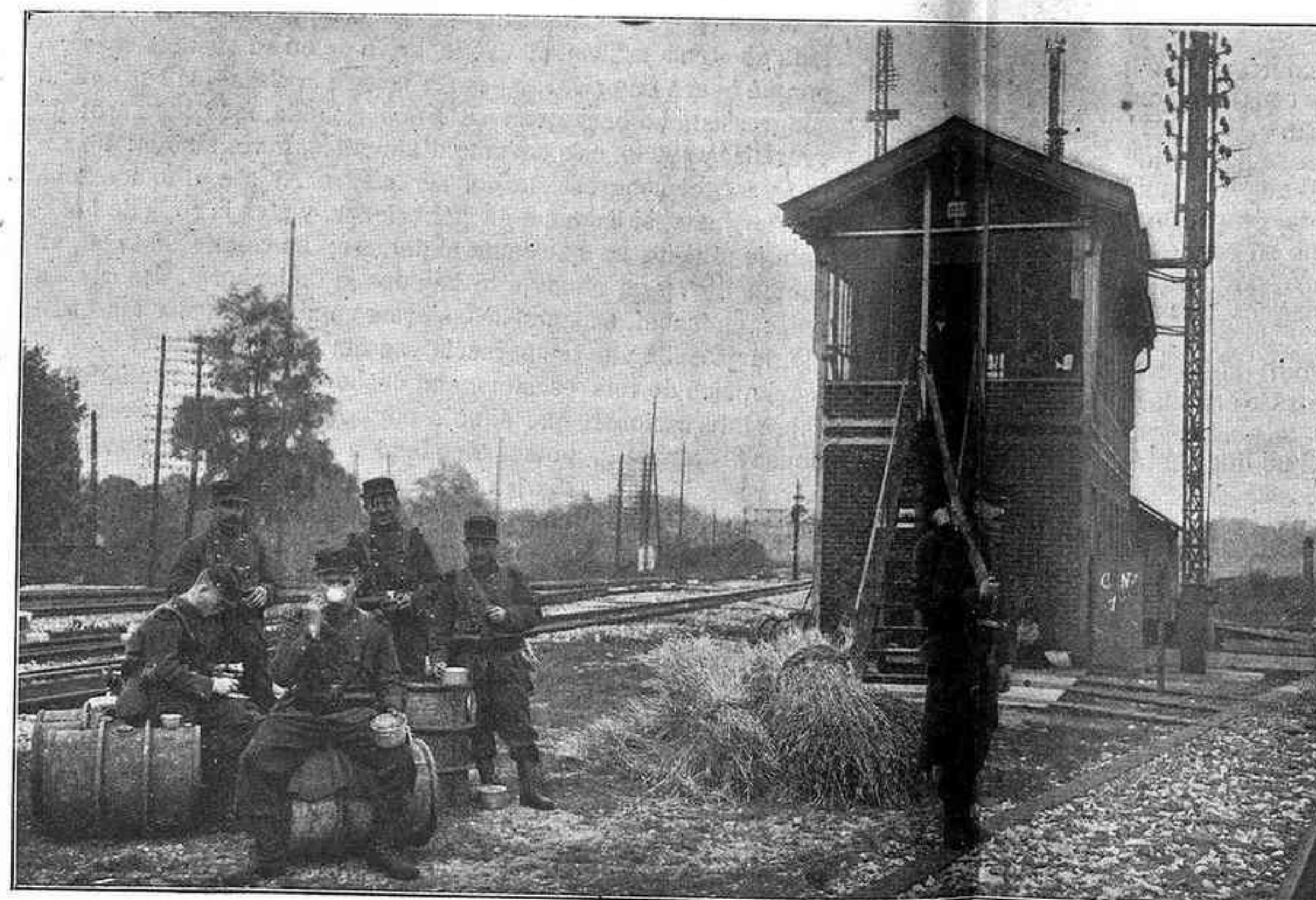
Servei de vigilància a la caseta de les agulles de Saint-Denis
