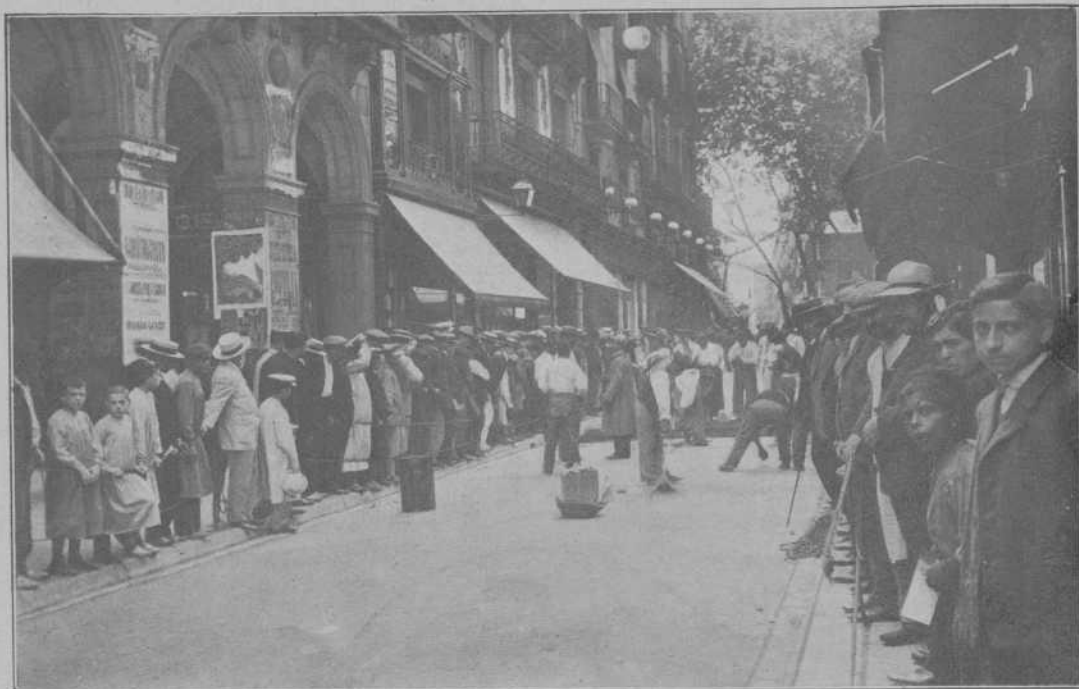
ASFALTAT D' UN TROS DEL CARRER DE FERNANDO, PER VIA D' ENSAIG Va quedar llest el dia 20 del present Agost. ¡A veure quánt durará!
