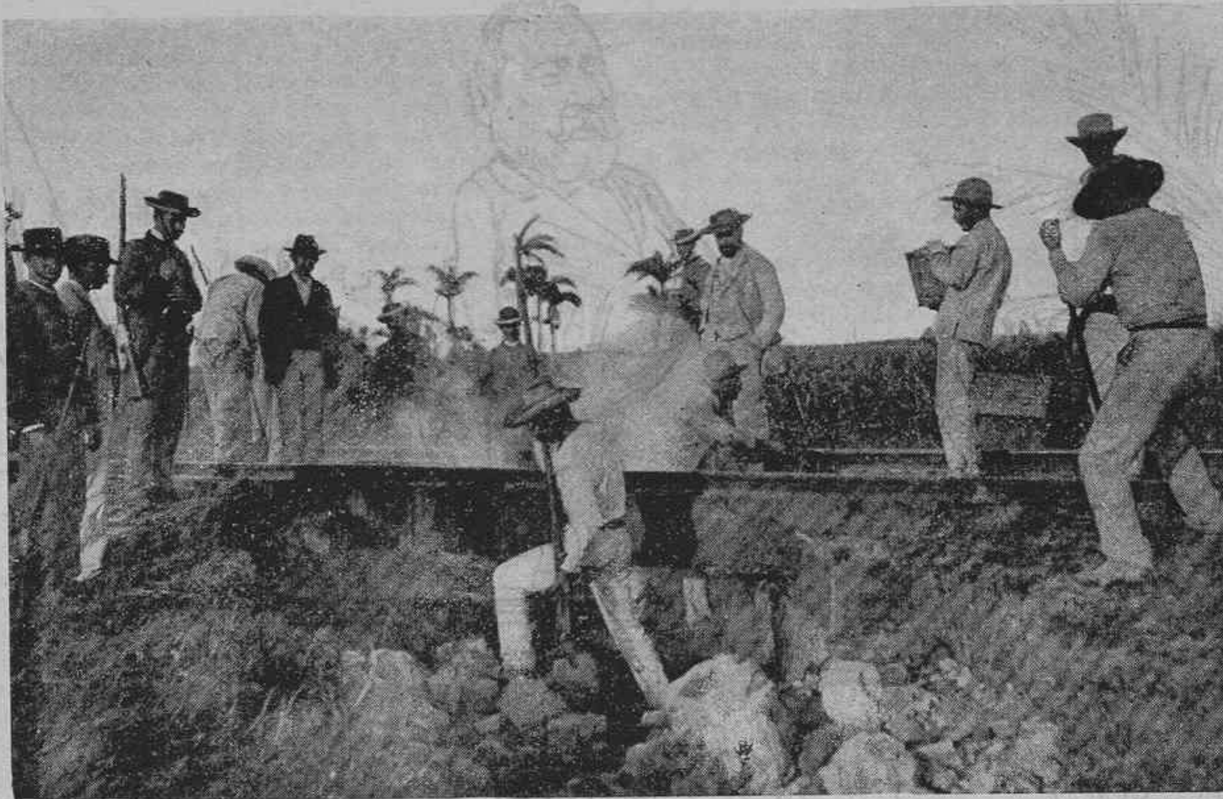
Línea férrea de Cienfuegos á Sta. Clara. — Pont sobre 'l riu Dolores, cremat pels mambissos.
