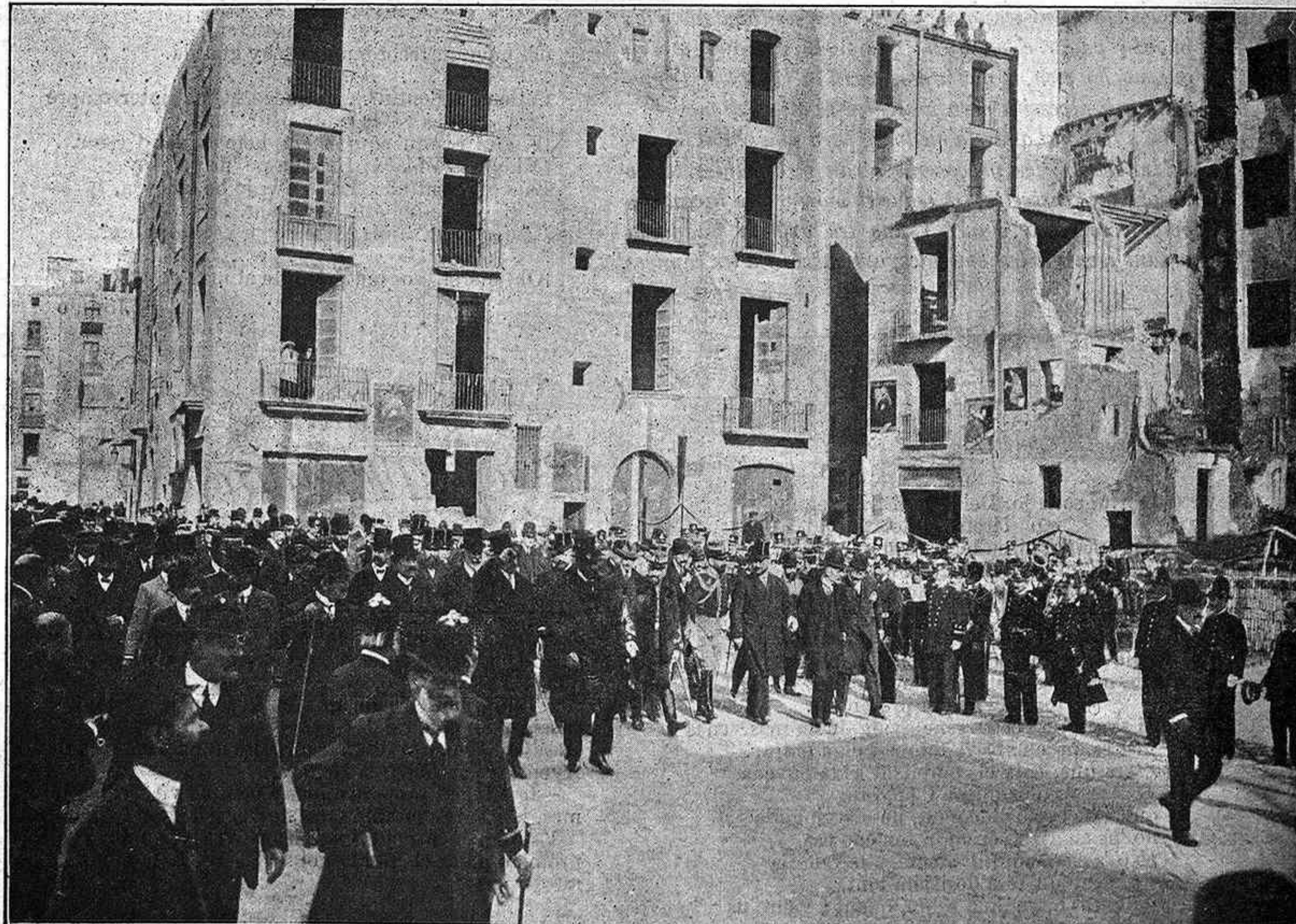
El rey recorre el tros obert de la primera secció de la vía A.
