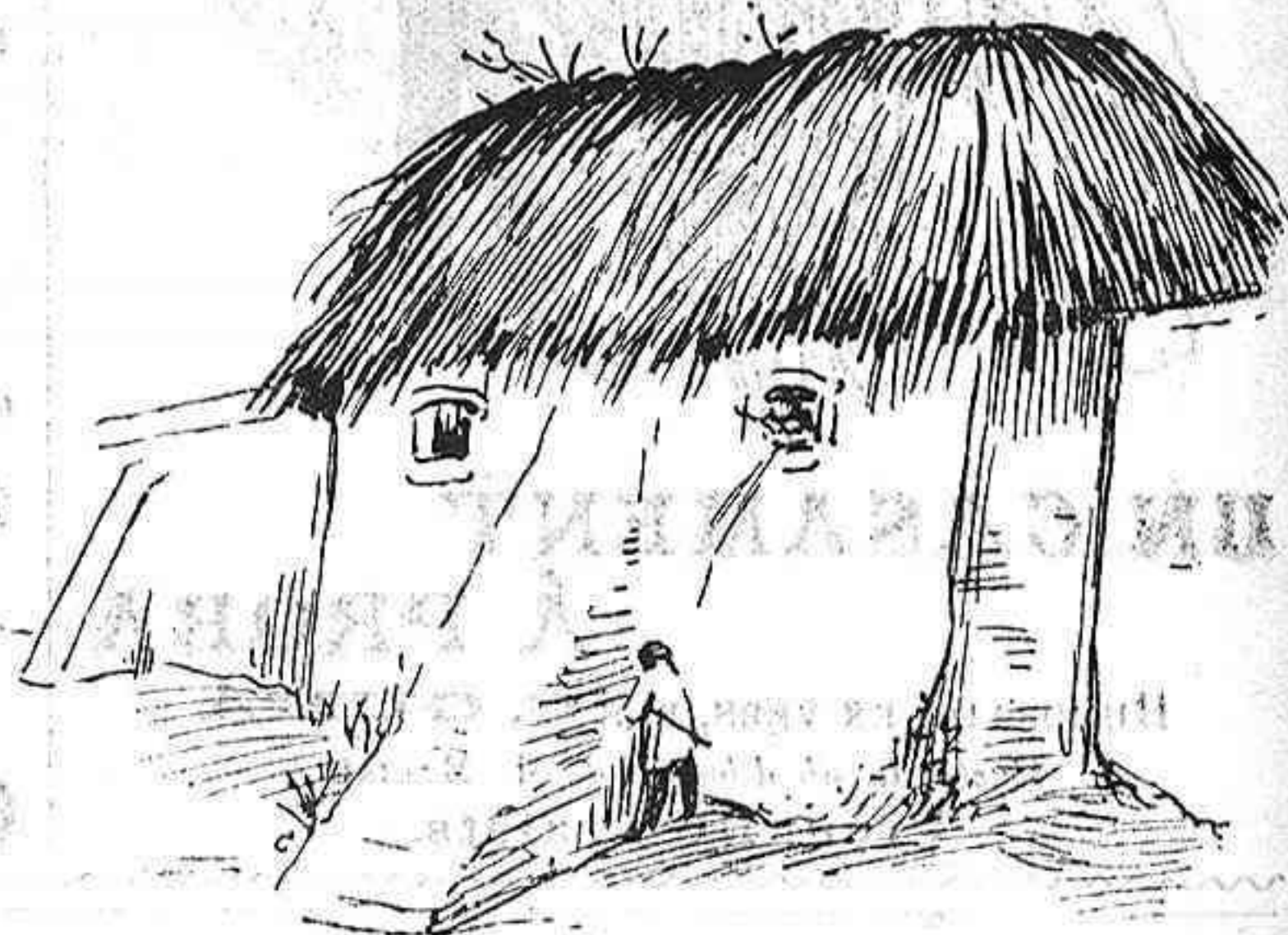
La casa mal pentinada.
