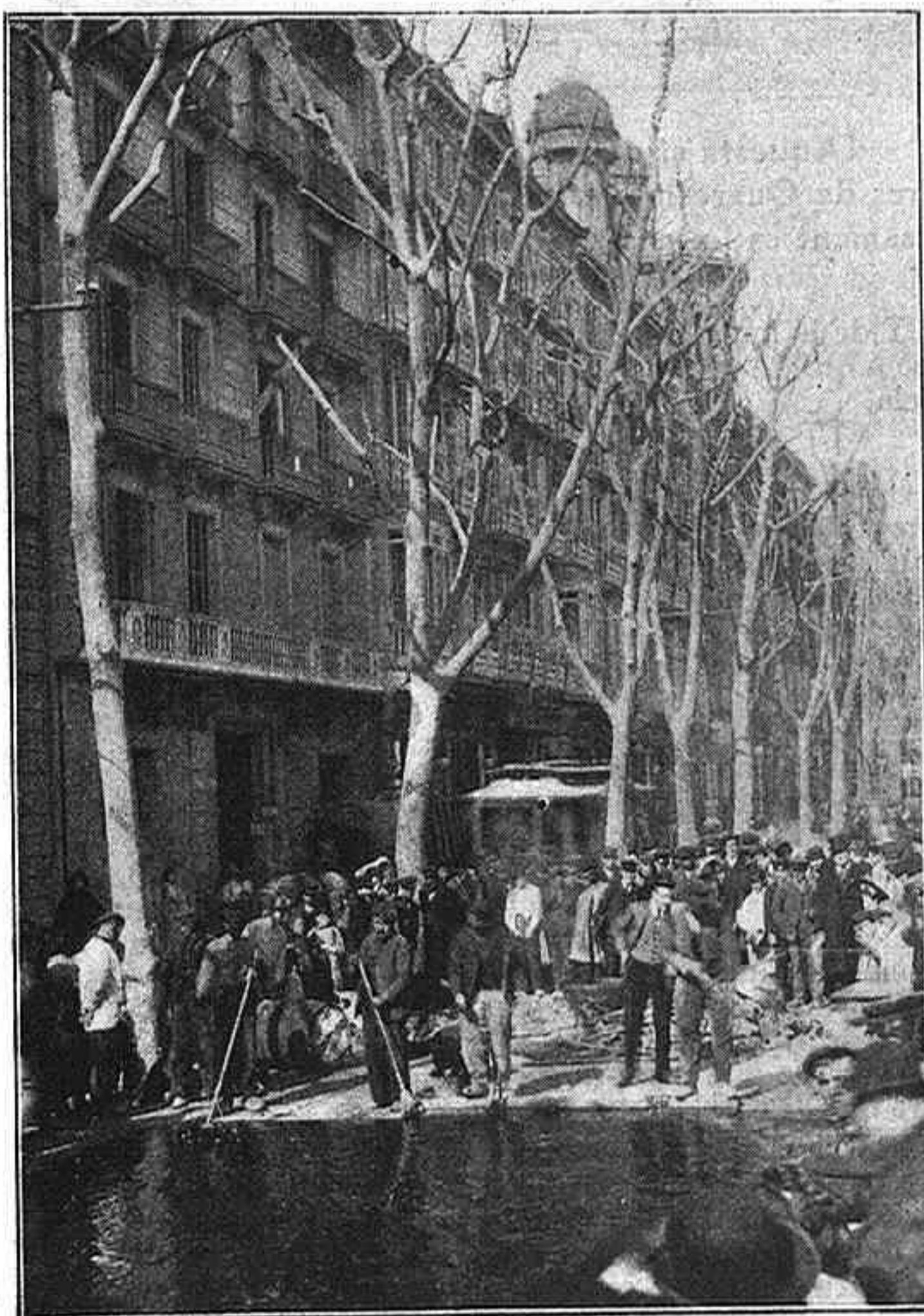
Tros de la rambla d' Estudis ahont se fa la proba del enquitranat del paviment.
