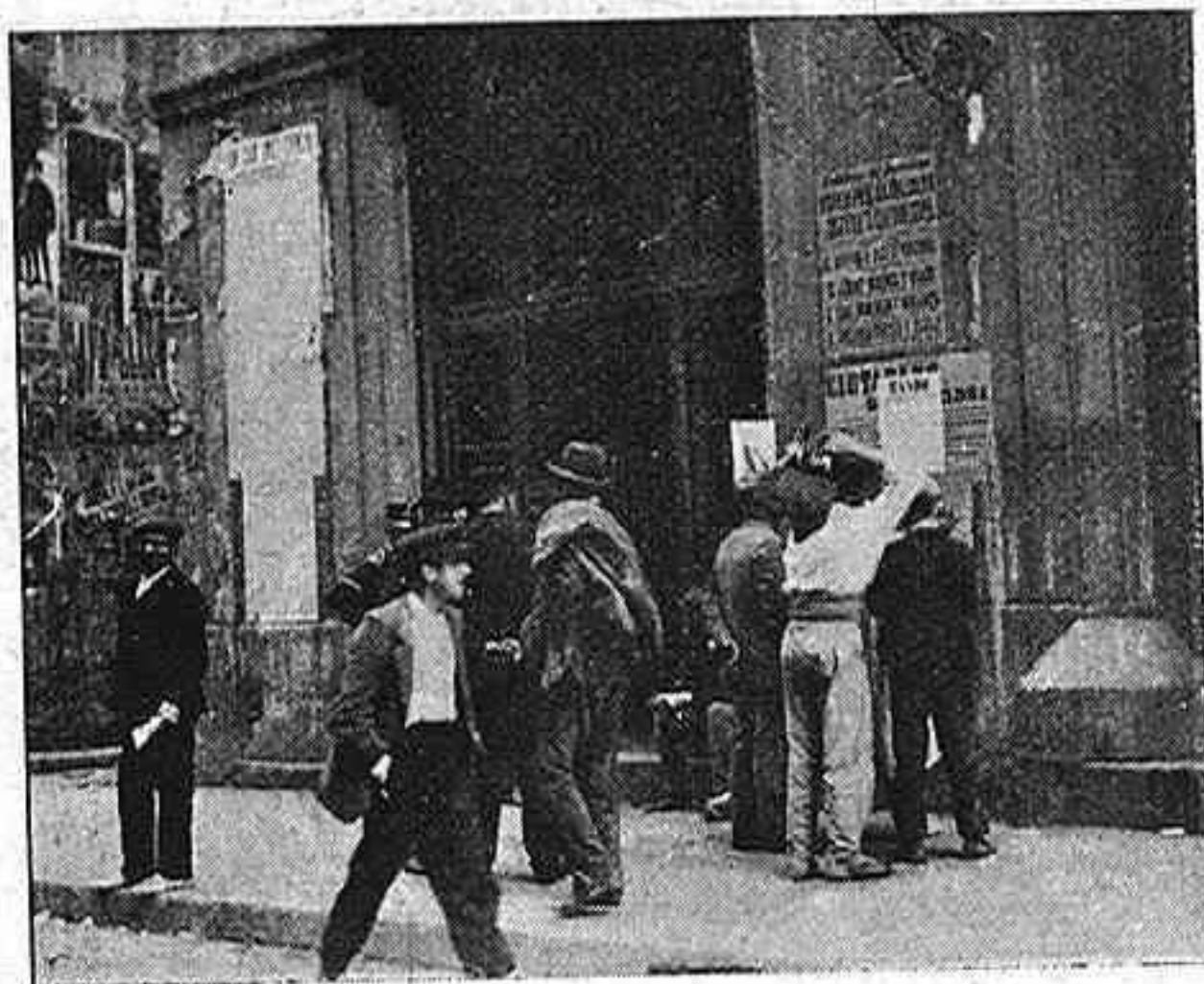
Quartelillo del carrer Nou.
