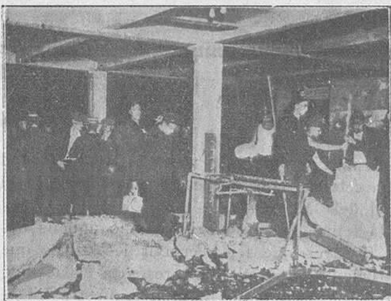
Les destroces causades per la bomba del Metro de Nova York
