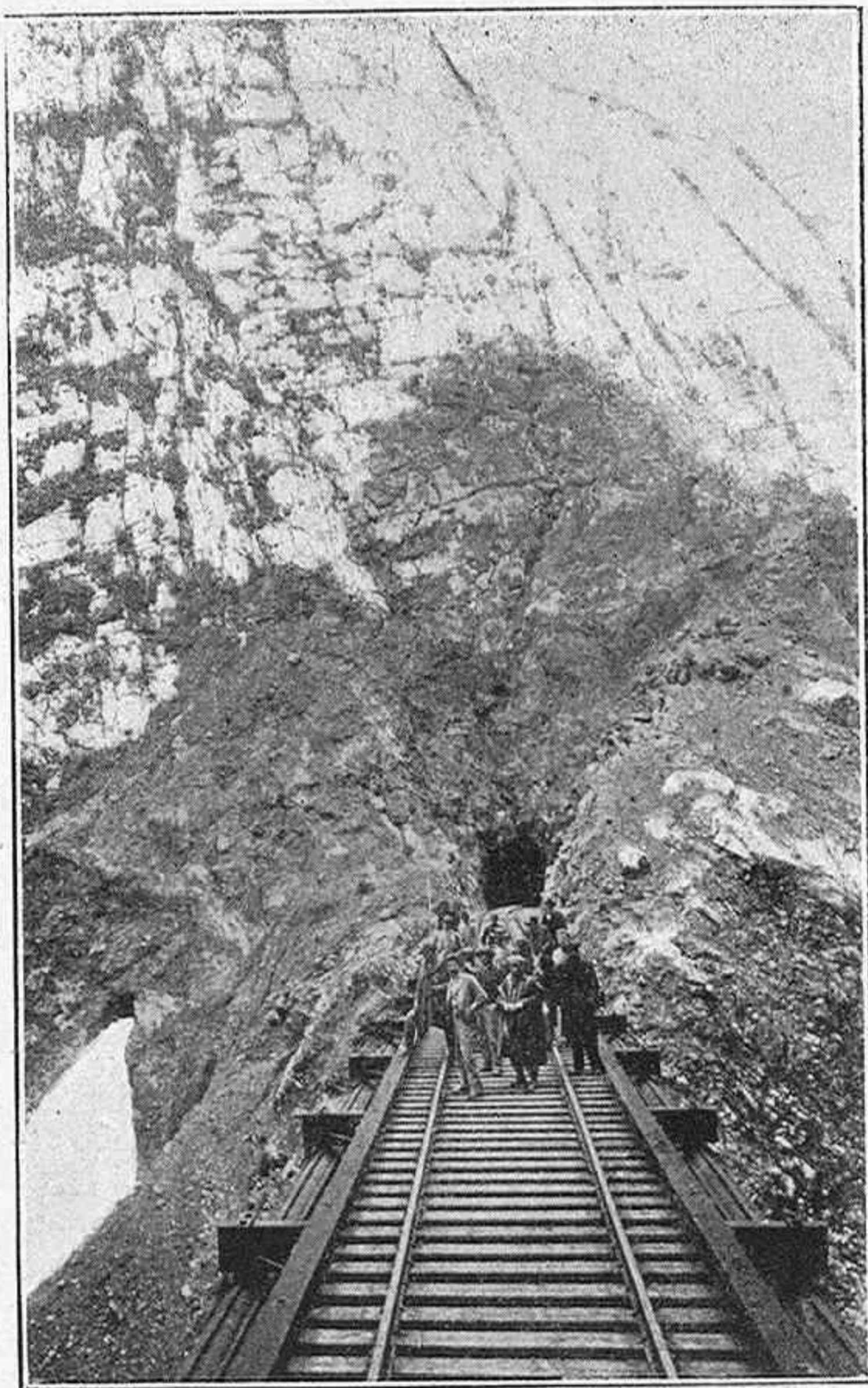
DERRUMBE EN EL FERROCARRIL TRASANDINO.
