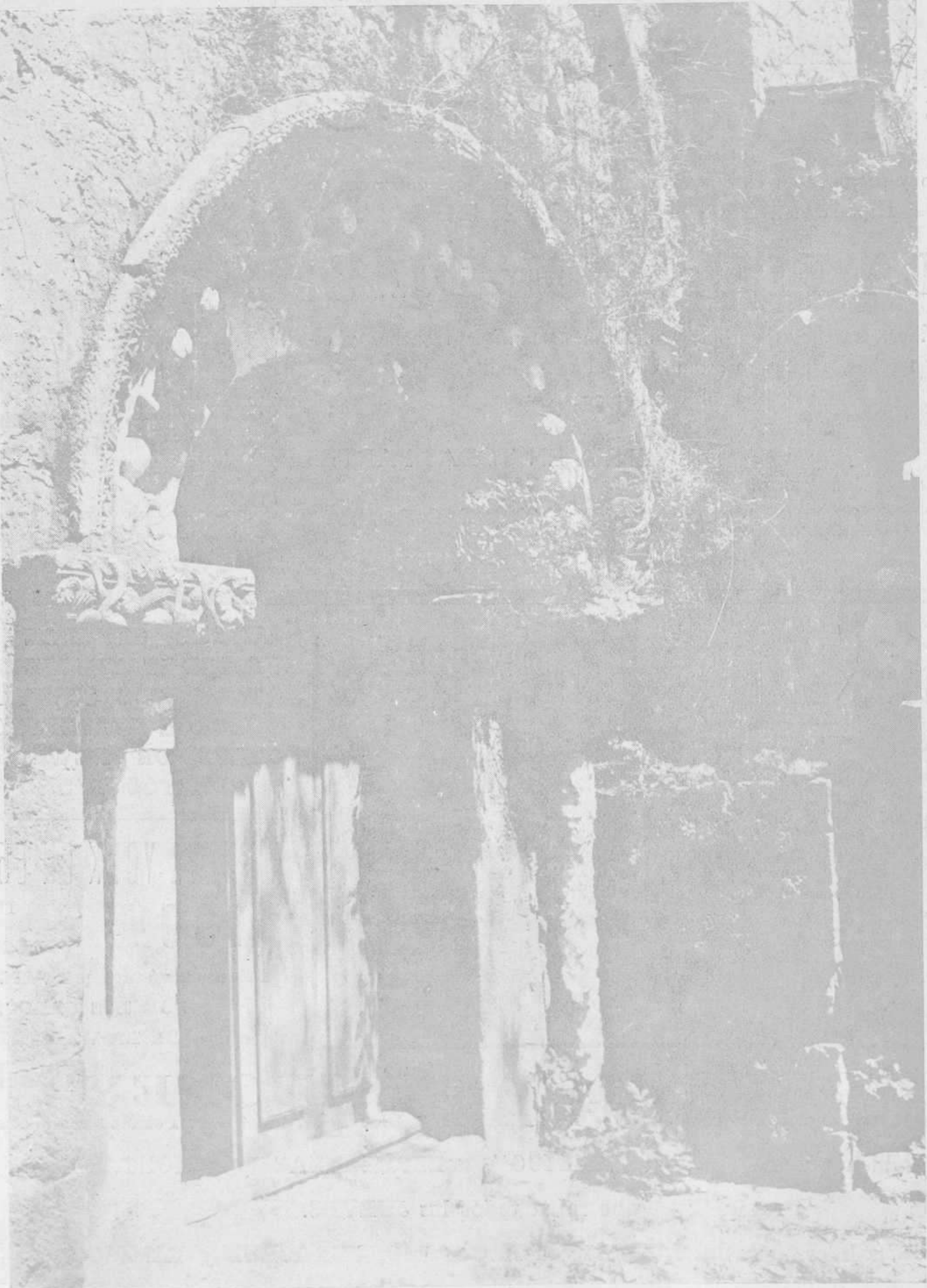
PIARCA.—Histórica puerta lateral del Monasterio medioeval que se conserva como una sagrada reliquia en dicho pueblecito montaños
