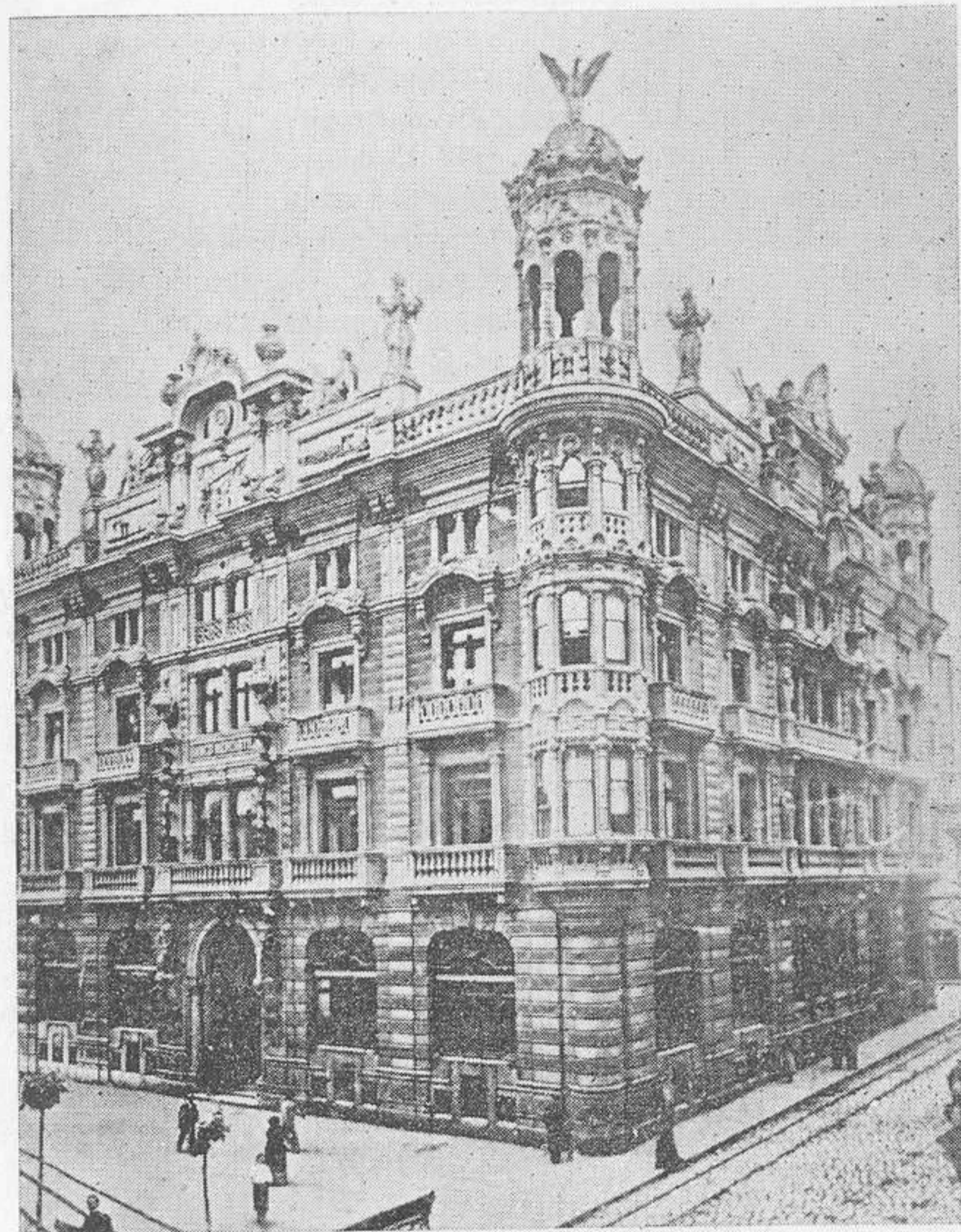
Aspecto del suntuoso edificio que posee el Banco Mercantil de Santander, donde tiene instaladas sus oficinas.
