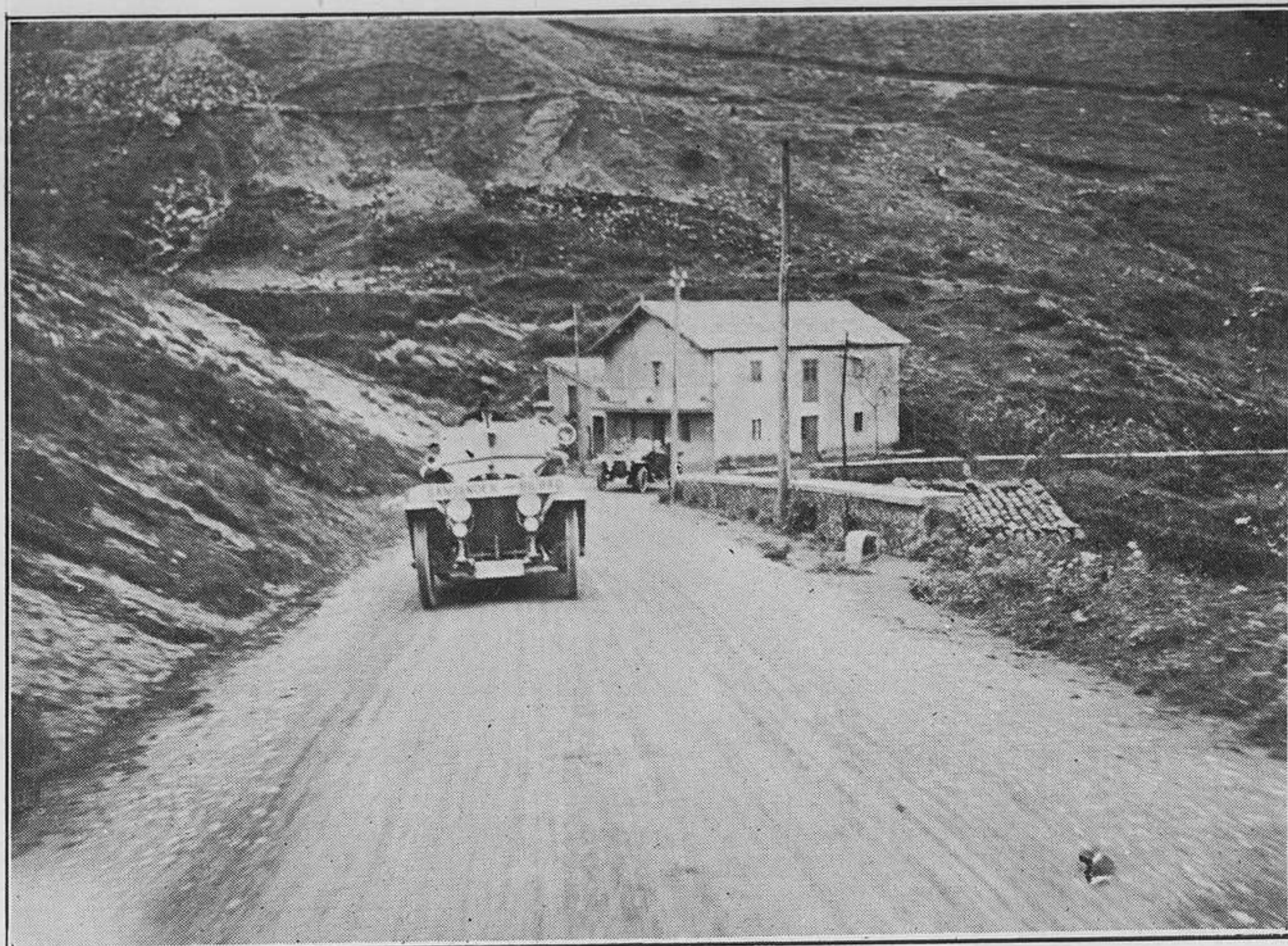
SANTANDER-BILBAO.—Un aspecto del nuevo servicio de turismo, suspendido recientemente.
