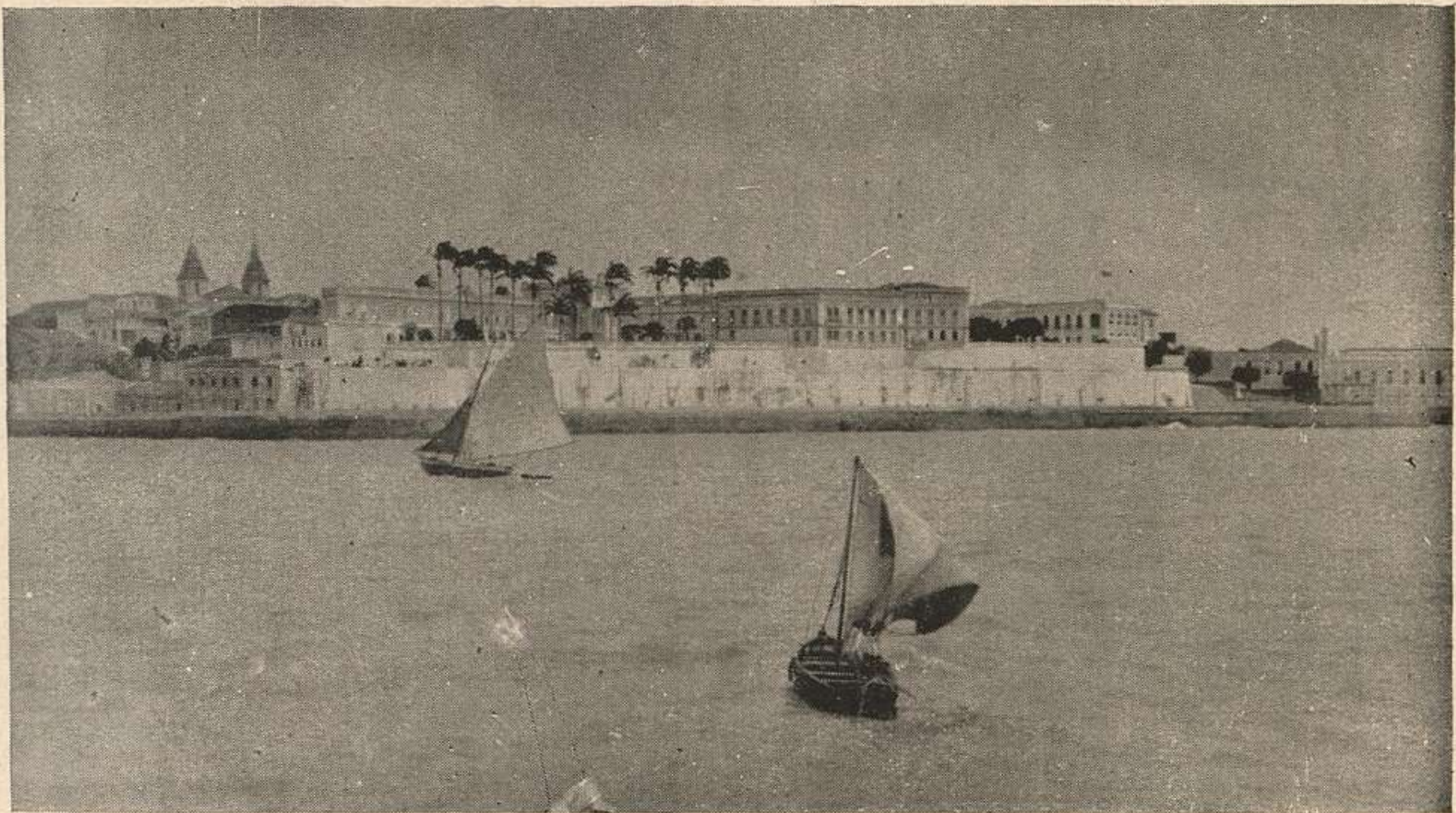
Vista de São Luiz. No primeiro plano o grande edificio do palacio do Governo (Phot. Fróes Abreu)
