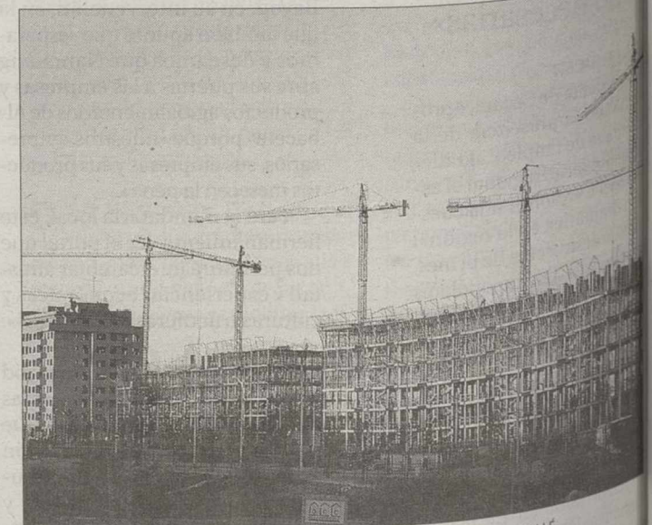
Edificios en construcción en la ciudad albaceteña. / RUBÉN SERRALLE
