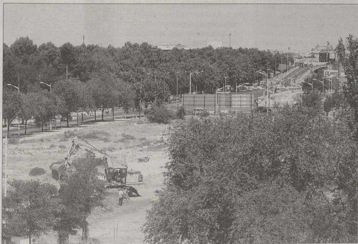
Vista aérea del último tramo del paseo de la Cuba, donde ya han comenzado las obras. / R. SERRALLÉ
