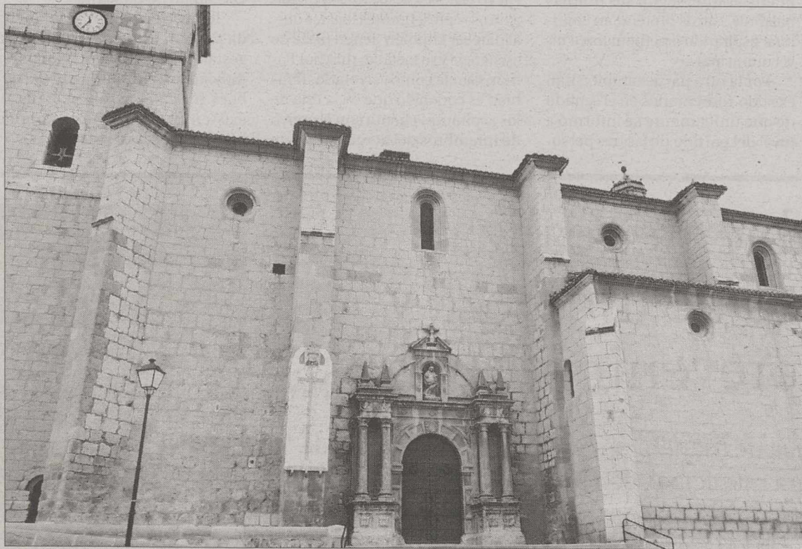
Vista parcial de la fachada de la iglesia de El Salvador, uno de los principales monumentos de La Roda. / A. VICO
