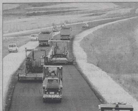
Obras de mejora del firme. / J.J.M.
