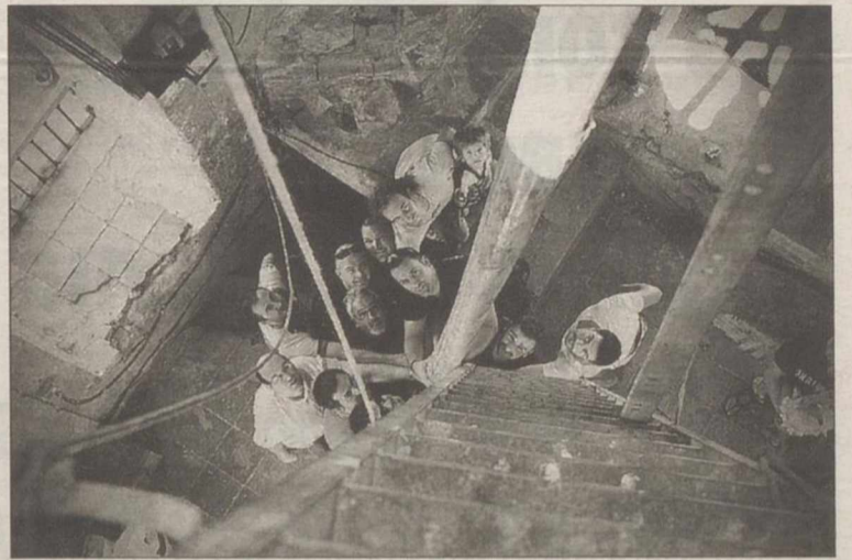
Momento en que el palo es izado a la torre. / J.D.S.A.
