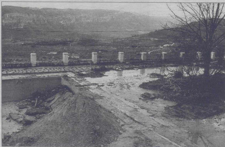
Trabajos de enterramiento en la actual piscina. / PP
