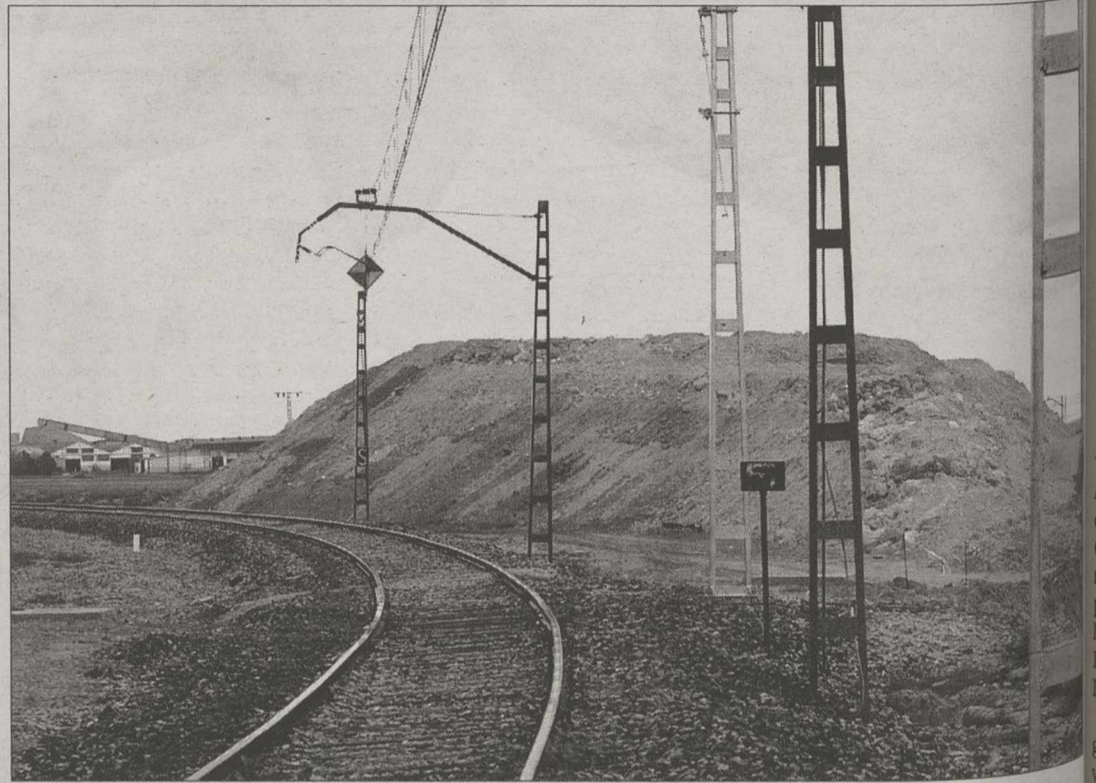
Obras de preparación del tren de alta velocidad, en las cercanías de Albacete. / ARTURO PÉREZ
