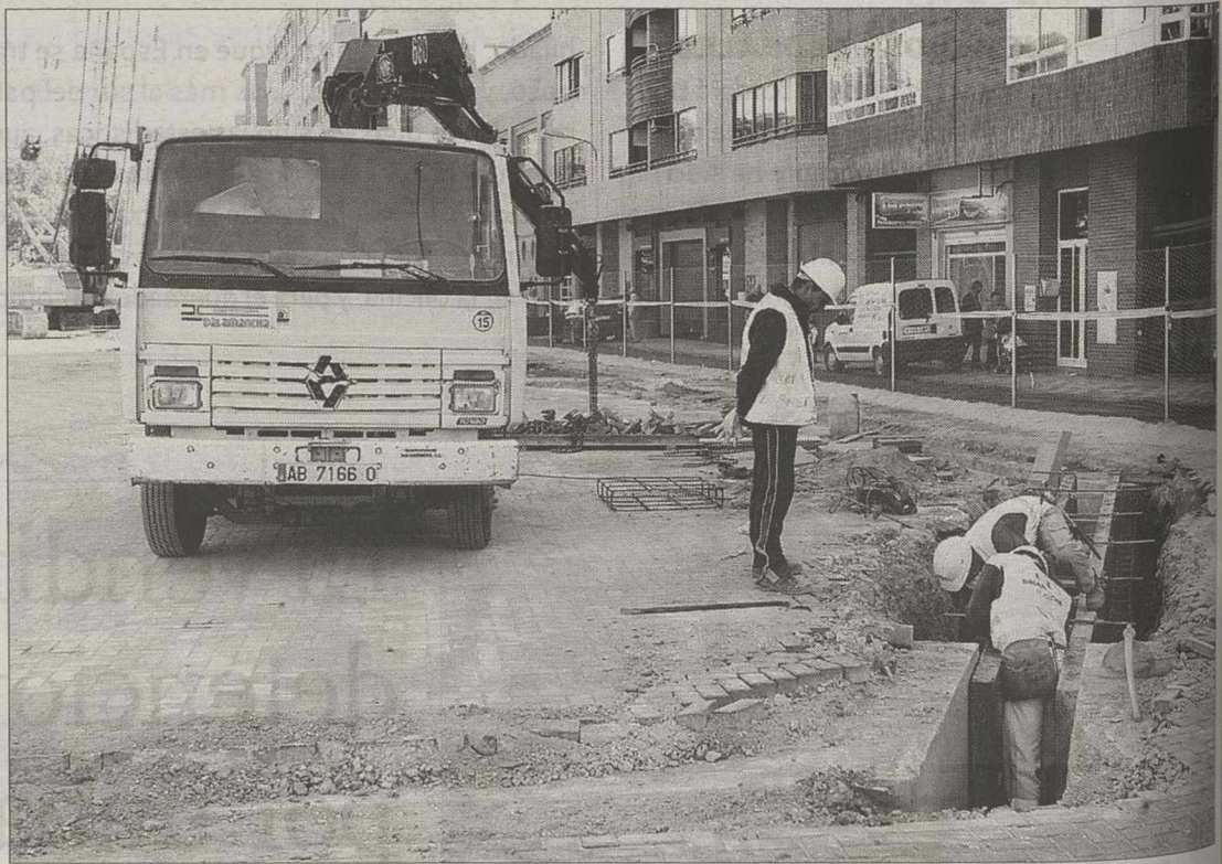
Los operarios de Lubasa ya trabajan contrarreloj en las obras para construir en aparcamiento de la Feria. / RUBÉN SERRALLÉ
