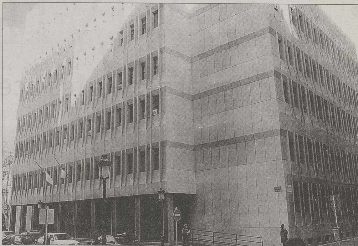
Fotografía del Palacio de Justicia de la capital albaceteña, en donde están ubicada la Audiencia Provincial. / C.LÓPEZ
