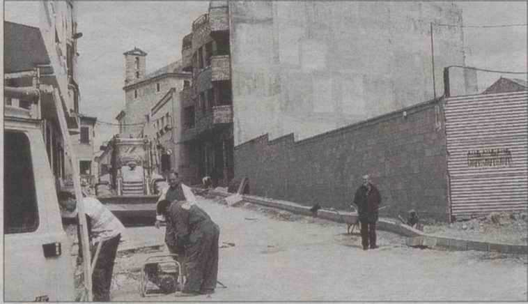
Estado actual de las obra en la calle Estación./TERESA JIMÉNEZ
