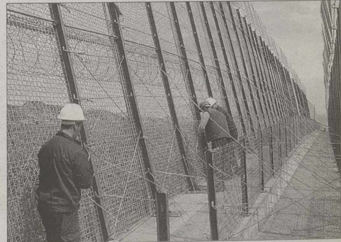
Varios operarios trabajan en la nueva barrera melillense. / EFE
