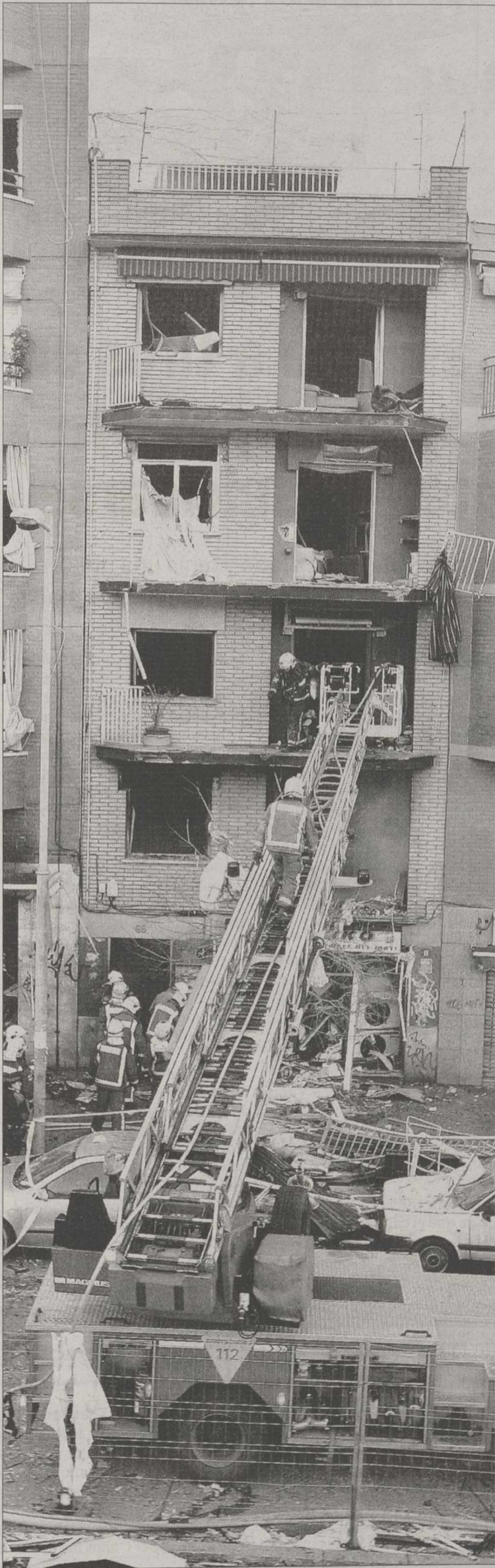
La brutalidad de la explosión obligará a demoler el inmueble afectado. / EFE
