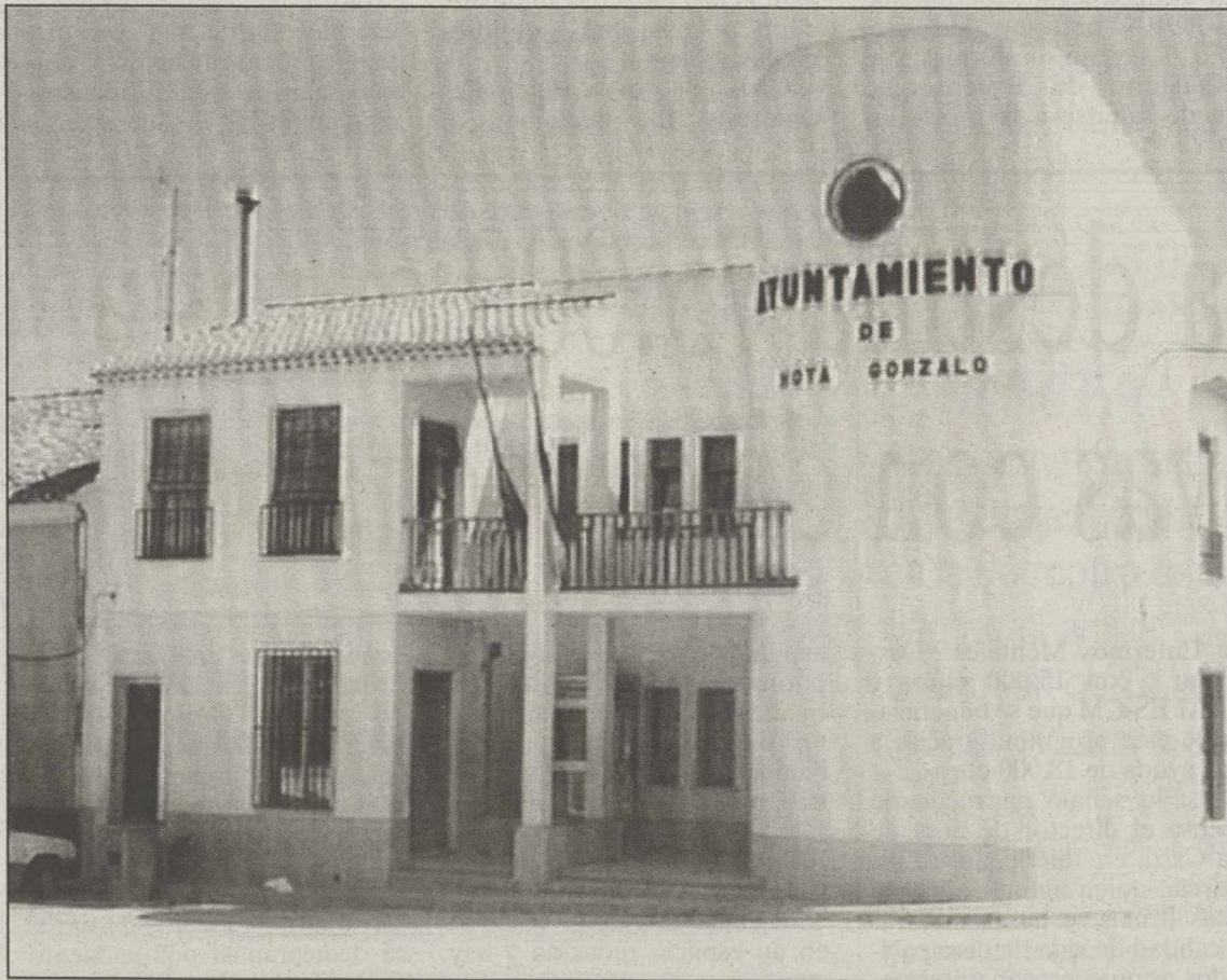
El Ayuntamiento firmó un convenio con Telecom para la construcción del repetidor. A
