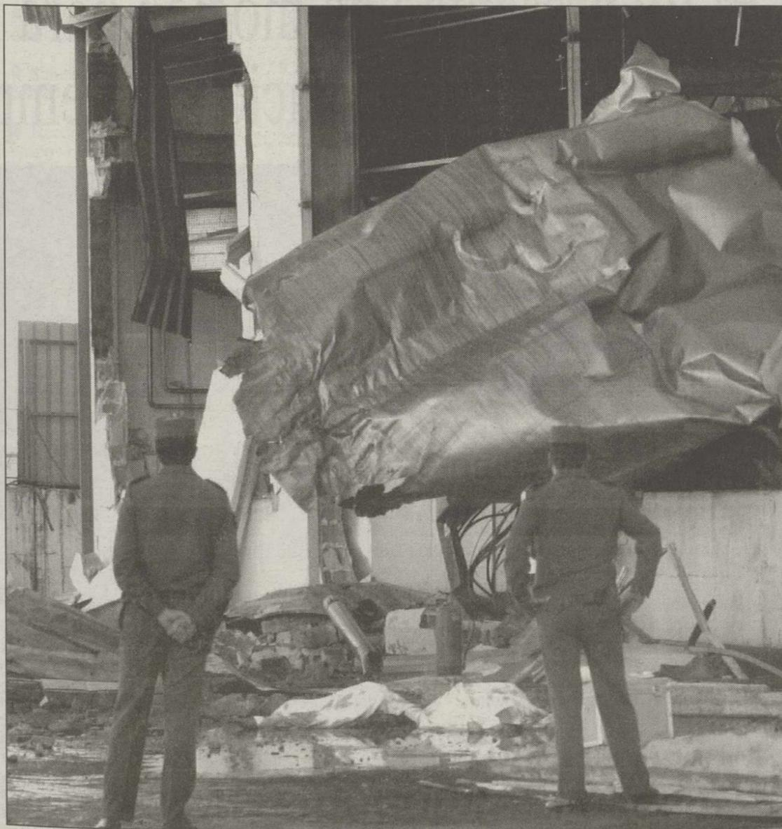
Una chispa de soldadura y gases inflamables del orujo de aceite, posible causa.
