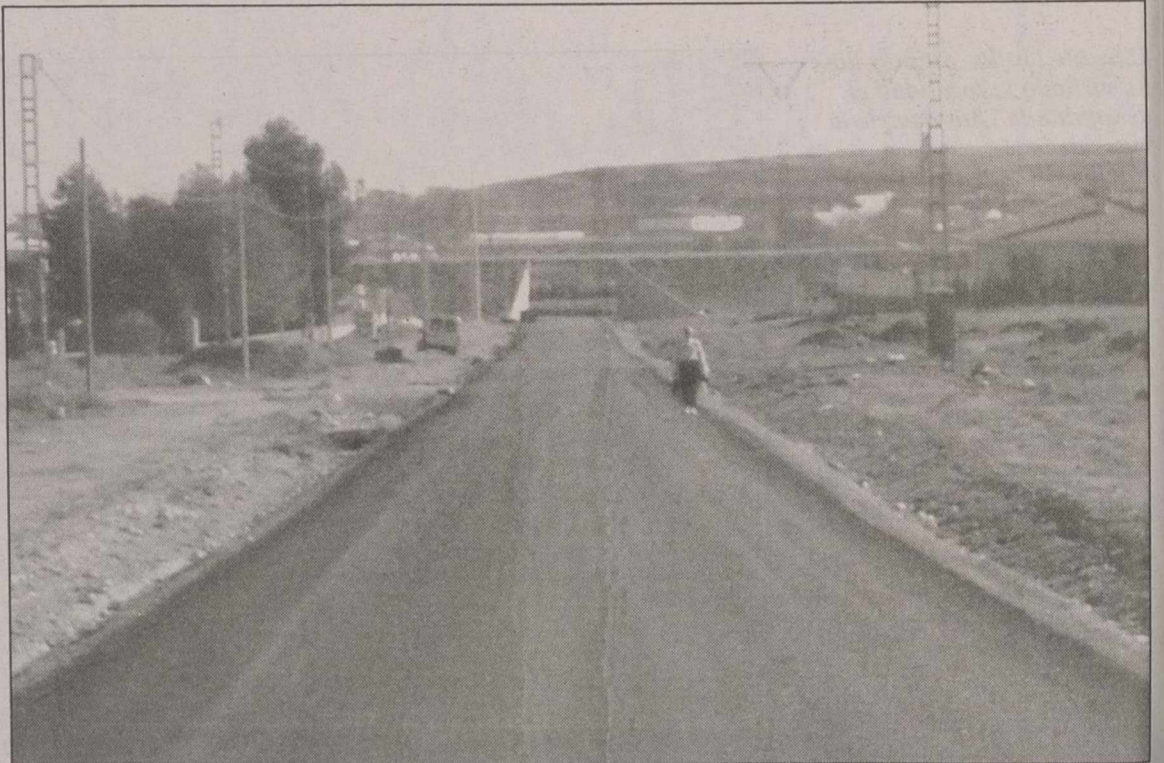
Obras de acondicionamiento de diversos caminos rurales.
