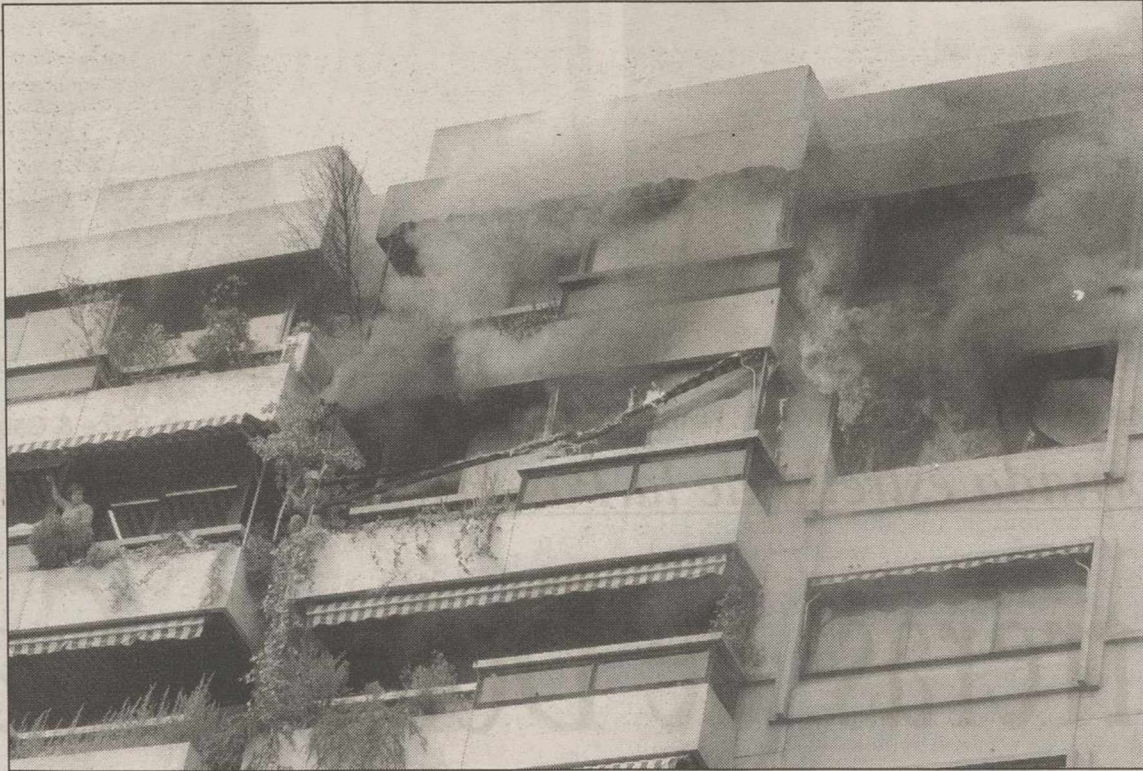
El incendio se inició en la tercera planta, desde donde se propagó hasta el último piso.
