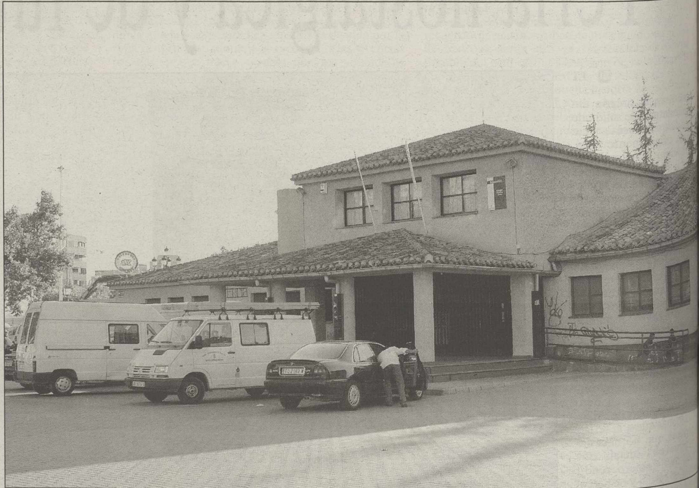
El puesto de atención de urgencias médicas estará ubicado en el colegio Feria, junto al Recinto Ferial.
