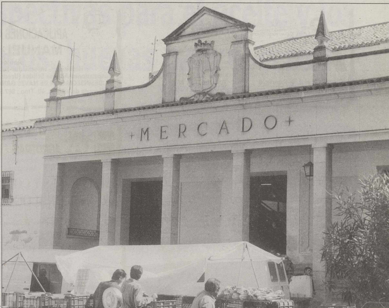
Fachada principal del Mercado Central de Almansa.
