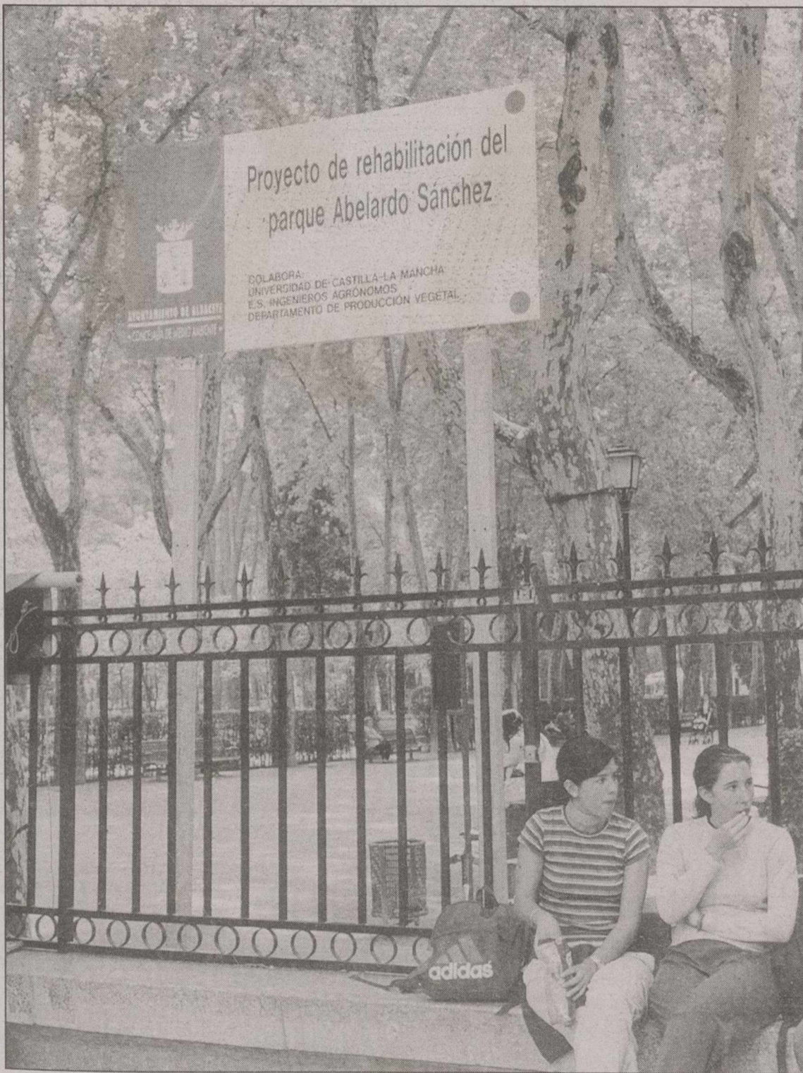
El Parque se encuentra en estos momentos cerrado por las obras.
