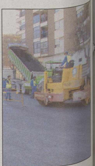
Asfaltan el Paseo de la Cuba.
