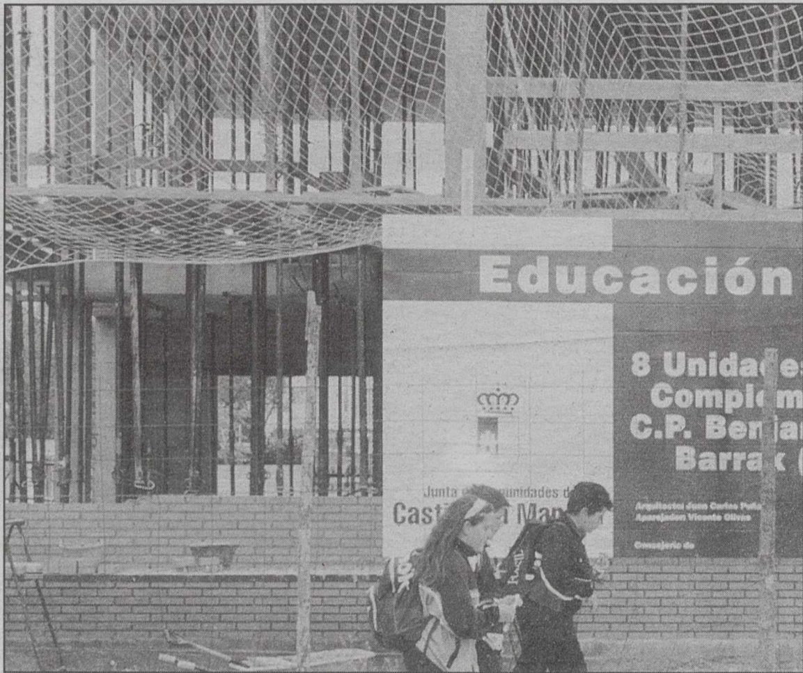
Obras de ampliación del colegio público de Barrax.
