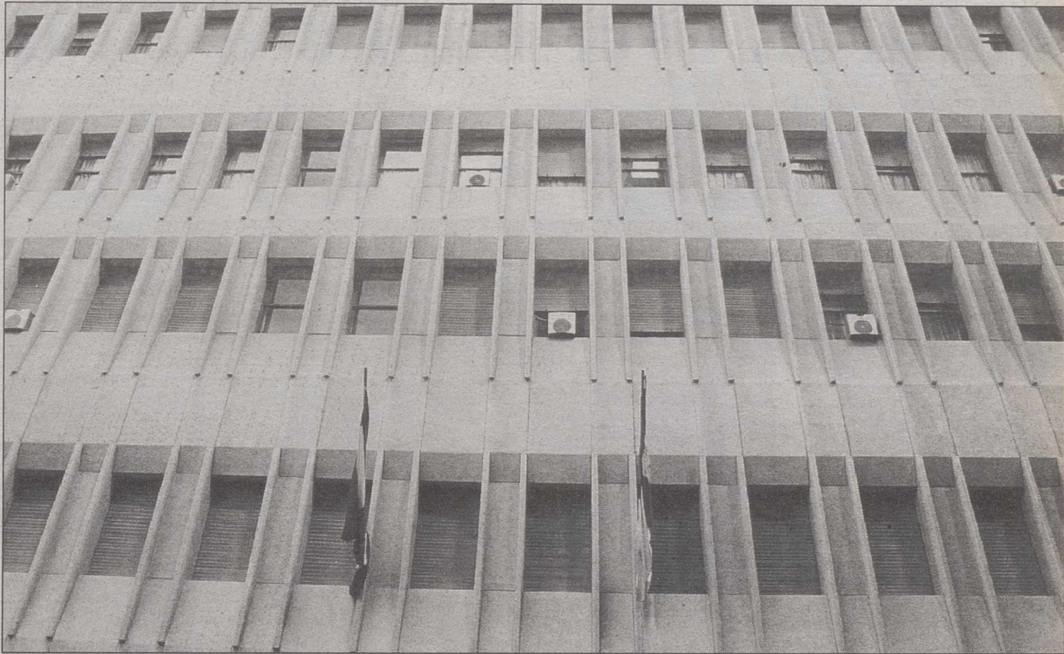
A fin de evitar molestias las dependencias afectadas se trasladarán a los espacios habilitados en la primera y en la tercera planta.
