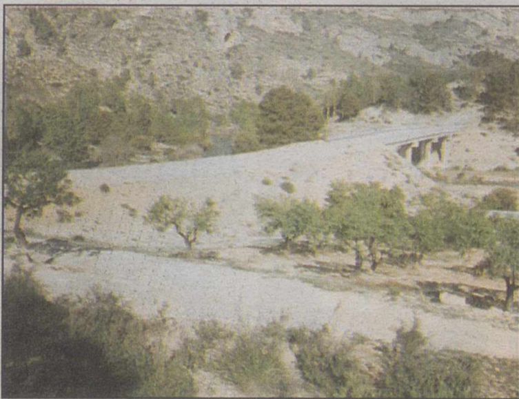
Trazado de la carretera a su paso por el río Segura.
