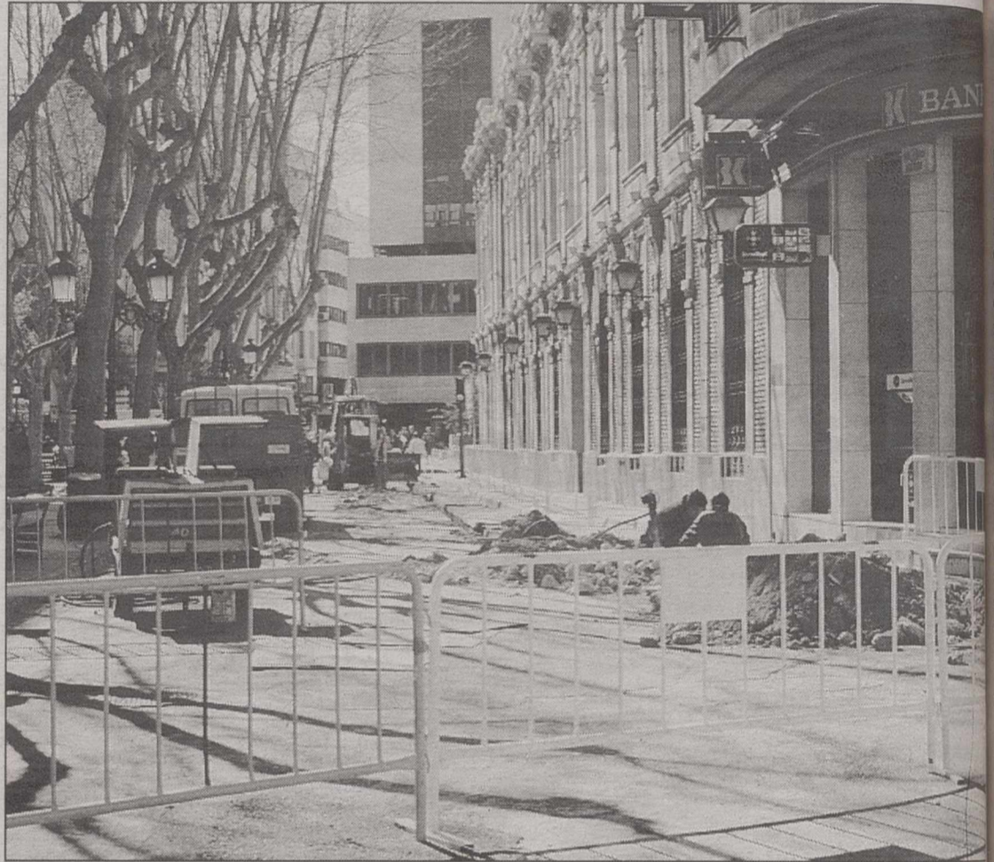
ONO está abriendo zanjas en el centro para cablear la ciudad.
