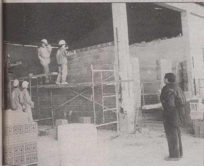
Los alumnos construyendo el muro en la nueva obra.
