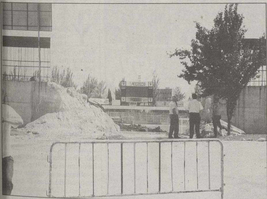
Pese a la polémica, comenzaron ayer las obras.
