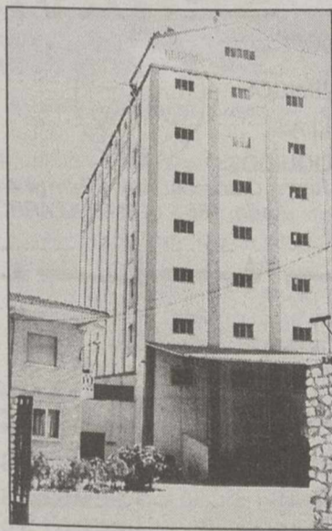
Silos para la Intervención.
