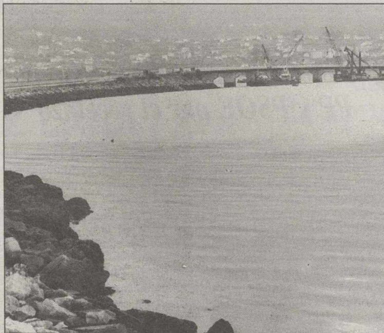
El puente de As Pías de la ría ferrolana volvió ayer a abrirse al tráfico.
