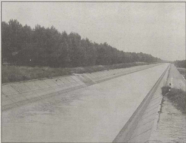
Habrán nuevas peticiones de agua para abastecimiento y riego.
