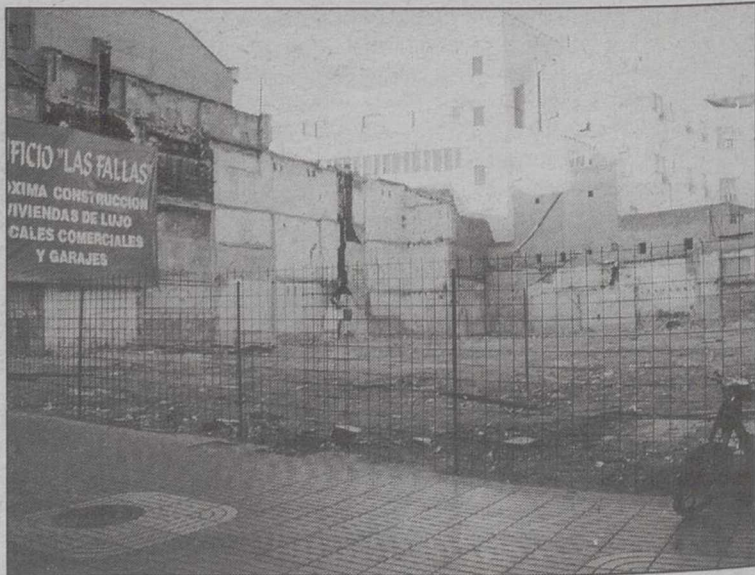
La obra de la calle Concepción sigue dando coletazos.
