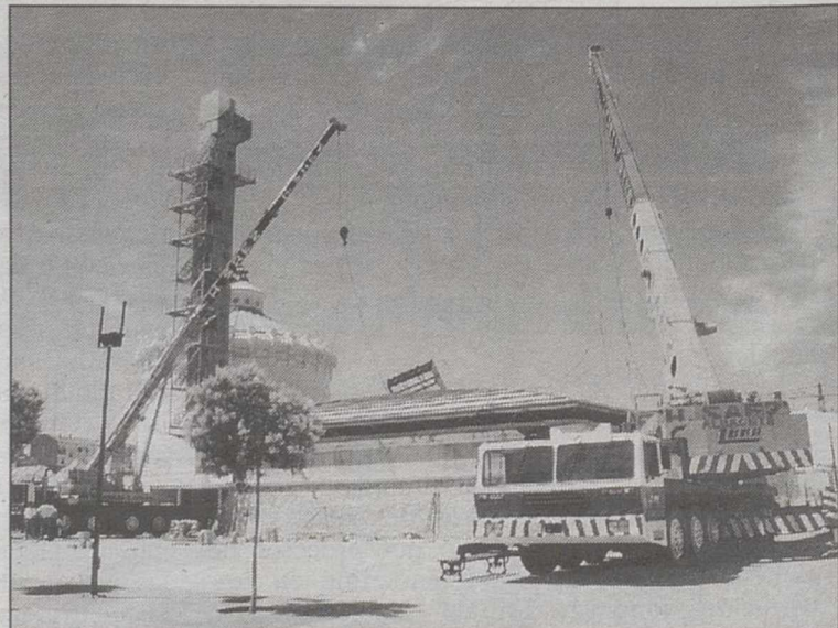
El pasado miércoles hubo algunos problemas en las obras.
